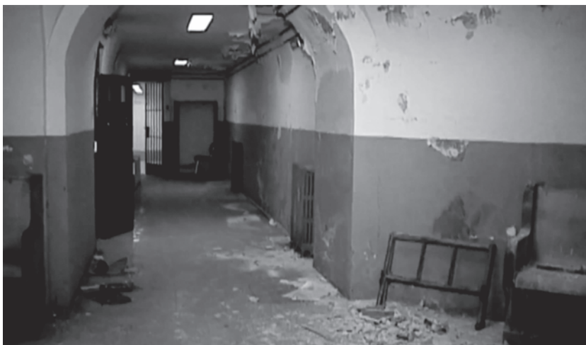
Entrada a los calabozos de la DGS Puerta del Sol Madrid
